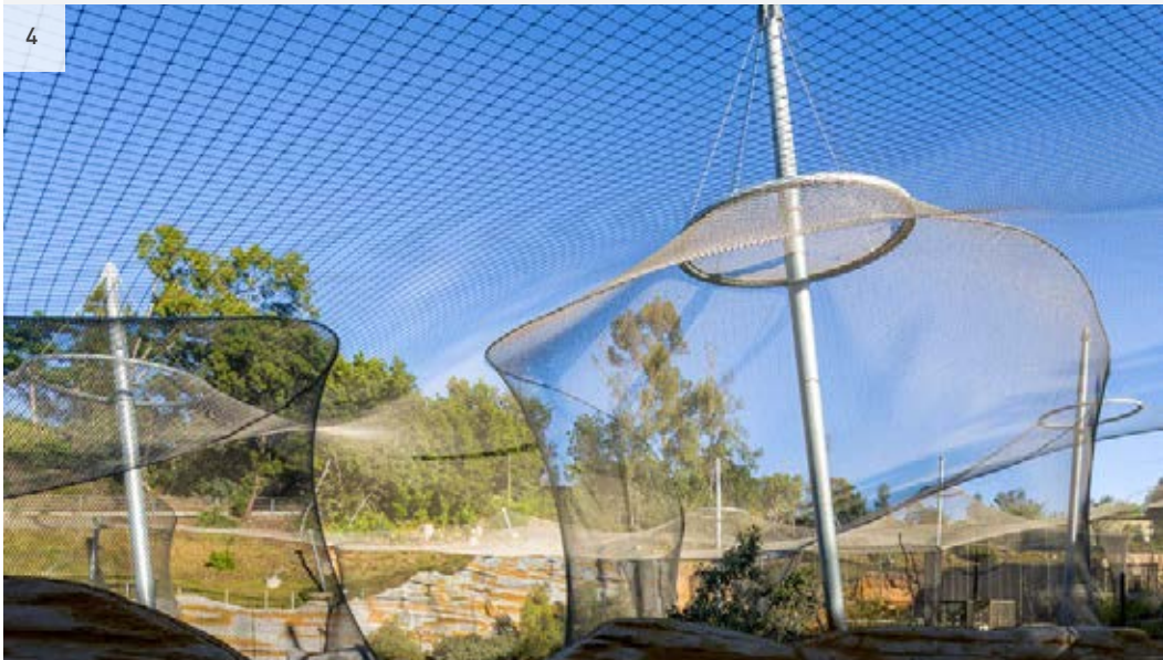
Wandnetze mit optimiertem, und somit optisch reduziertem Dachnetzanschluss Wall mesh with optimized and thus almost imperceptible attachment to the roof mesh
