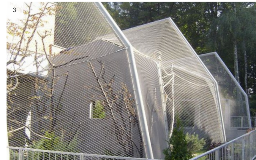
Außengehege mit Separierung, mit fließender Netzüberdeckung Exterior enclosure with separate units, and with continuous mesh cover
