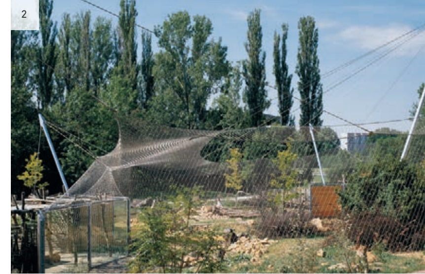
Löwengehege mit von außen spannenden Pylonen Lions enclosure with pylons tensioning from the outside
