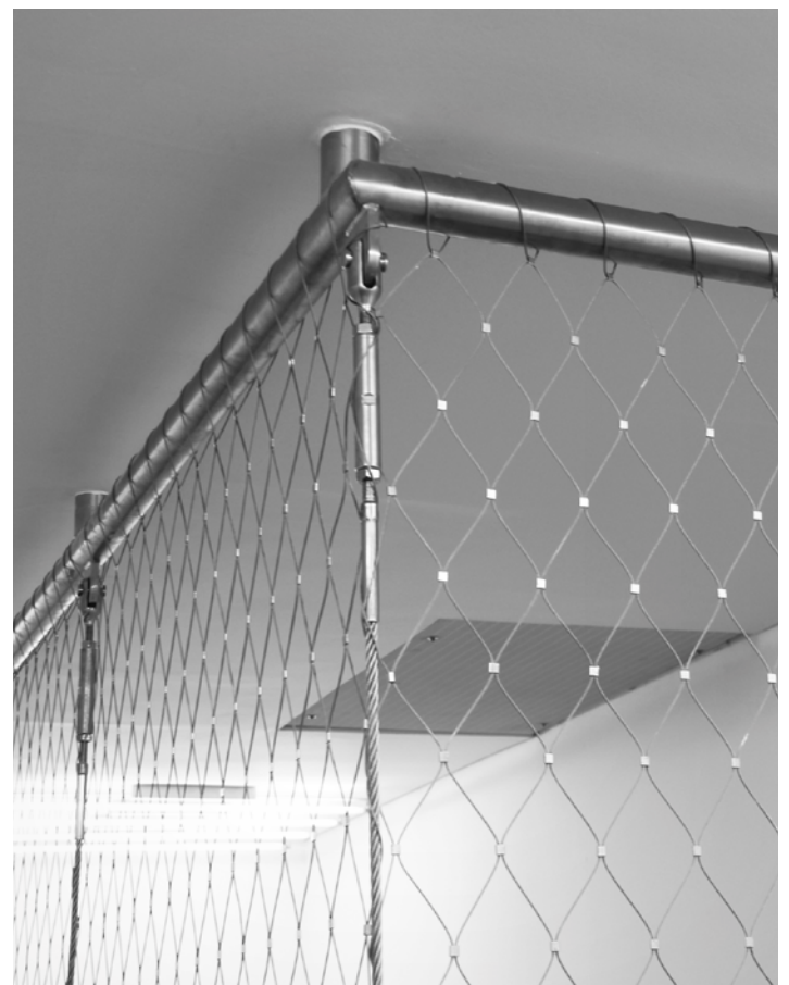
10 Treppensicherung Seilanschluss Staircase protection, cable connection
