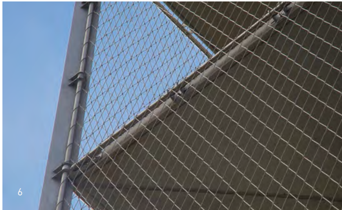
1 Hubschrauberlandeplatz Netzrand, Rohr und Seil Helicopter landing pad, mesh border, tube and cable
