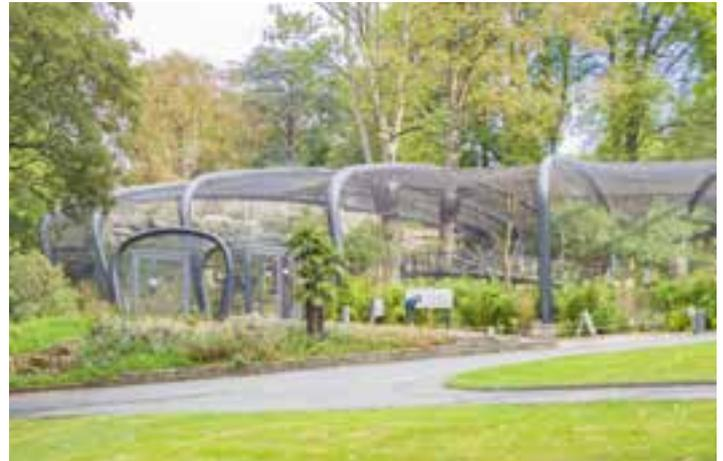
Fertig verschweißte Rahmen aus Edelstahl-Schlitzprofilen
