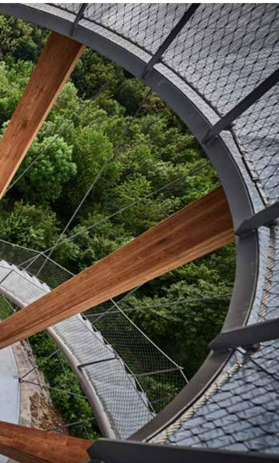
Geländerfüllungen zur Absturzsicherung an Balkonen und Wegen lassen sich filigran, unauffällig und sicher mit X-TEND Edelstahlseilnetzen und I-SYS Seilen ausführen. Die Leichtigkeit der Konstruktion und die Langlebigkeit der Materialien überzeugen Planer und Nutzer. Mit dem Baukastensystem I-SYS und den unterschiedlichen Maschenweiten von X-TEND eröffnen sich zahlreiche Gestaltungsmöglichkeiten.
